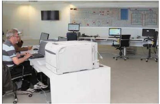
Диспетчерская комната новой водоочистной станции. Состояние работы всей станции контролируется отсюда. В местах возникновения проблем загораются красные лампы.
